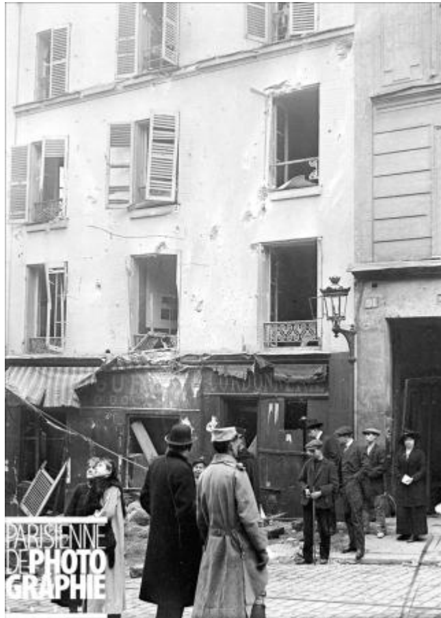
Guerre 1914-1918. Bombardement de Paris par un zeppelin. Maison criblée d'éclats, 89-91 rue de Ménilmontant (XXème arrondissement). 20 janvier 1916.
