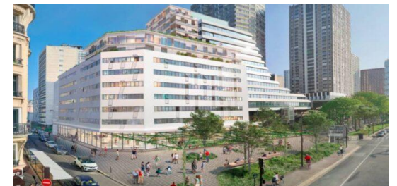
Garage automobile Renault transformé en logements (15 e )
